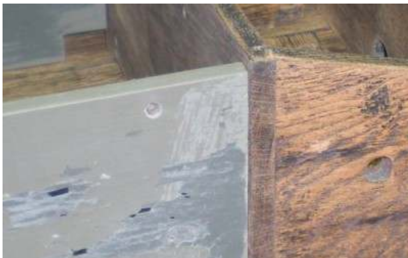
Bild 5. Skyddslådan för högspänningstransformatorn är försedd med sinkade hörn. Passformen är perfekt och limmet håller än. Kanske har äkta varmlim, baserat på kokta djurben och hudar, använts.
