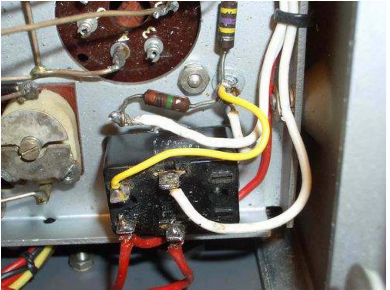
Frontpanelens BFO brytare
