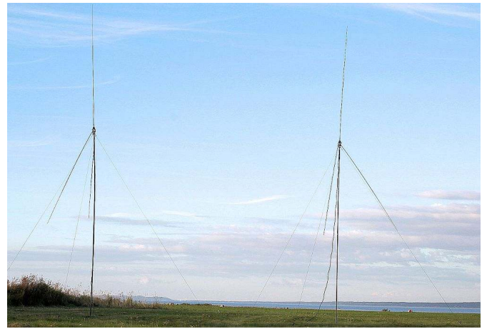
Resultatet av vedermödorna, två vertikaler med ett avstånd av en halv våglängd. Man ser att enbart två av de tre radialerna använts, detta för att lyckas få resonansen på 18,1 MHz.
