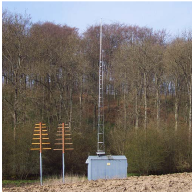
En takmonterad 15 meters antenn
