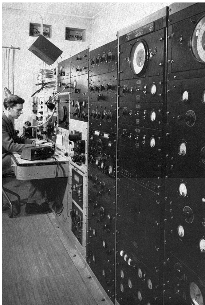
Mätplats från 50-talet å Kgl. Telegrafverkets kontrollstation i Enköping. General Radio-frekvensnormalen i förgrunden.
