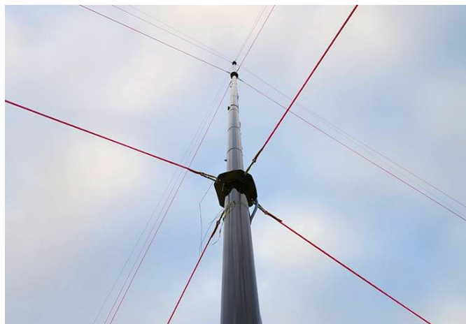
Glasfibermasten stagades med fyra linor i tre plan plus topplinor på 15,5 m höjd och radialerna 1 m över marken.
