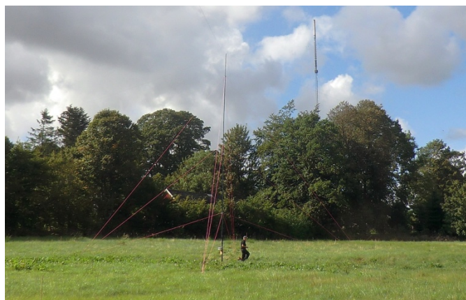
Glasfibermasten stagades med fyra linor i tre plan plus topplinor på 15,5 m höjd och radialerna 1 m över marken.
