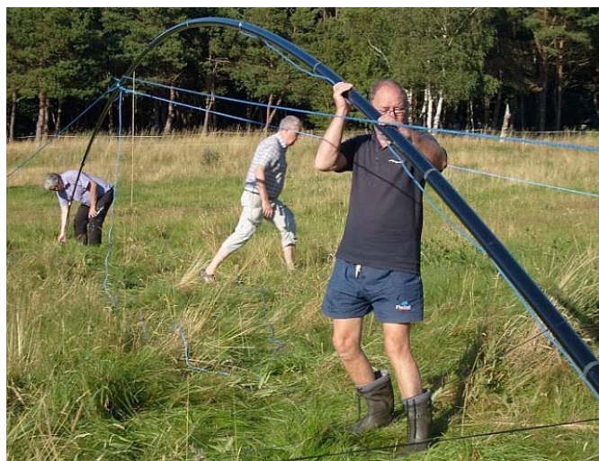
Vid första provresningen av antennen i mitten av augusti månad visade det sig emellertid att glasfibermasten var alldeles för klen i toppsektionerna.
