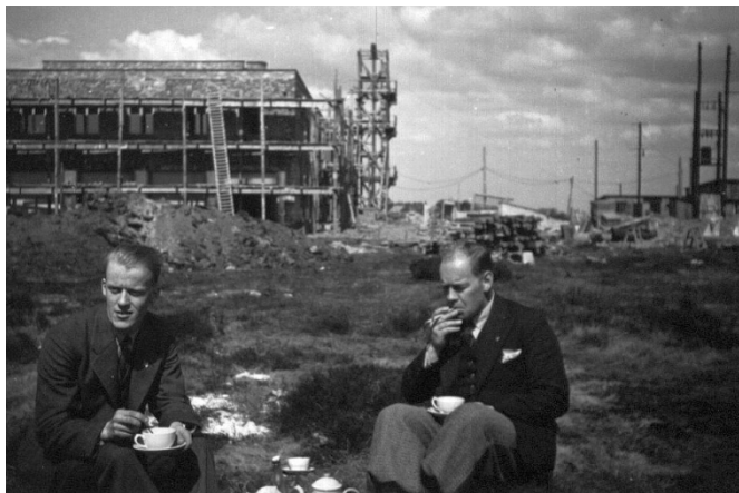
Stationsbyggnaden med två sändarsalar under uppförande.
