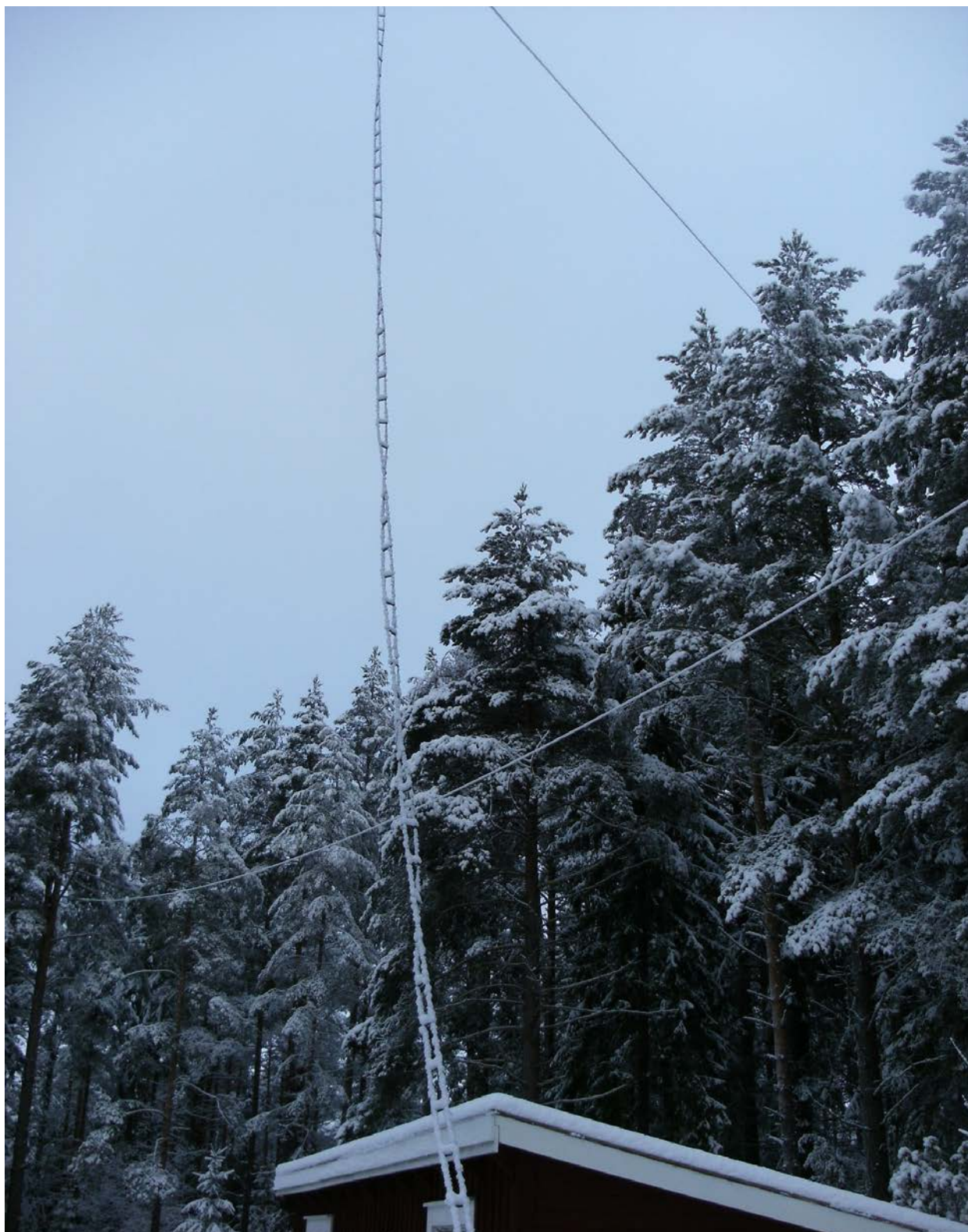
Stegmatad antenn i vinterskrud tillverkad av Dejan SA3BOW
