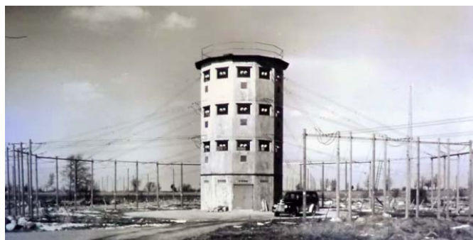
Ur bildarkivet: Kopplingstornet från 1952. Tre feederledningar monterade på trästoplar kommer från sändarsalen och i tornet finns en stor antennomkopplare - ett omkopplardäck på varje våning - för val av önskad antenn.
