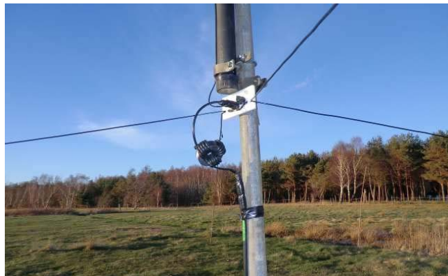
Den tredje antennen placerades på en stor sandig betesmark c:a 250 m in på land från stranden som finns i riktning c:a 300 grader, d v s mot målområdet i USA. Bilden ovan visar hur matarkabeln kopplats in via en strömdrossel som ger 50 dB common mode dämpning på 7 MHz, mätt i en 50 ohms testjigg. Likadana strömdrosslar monterades på de två andra antennerna.
