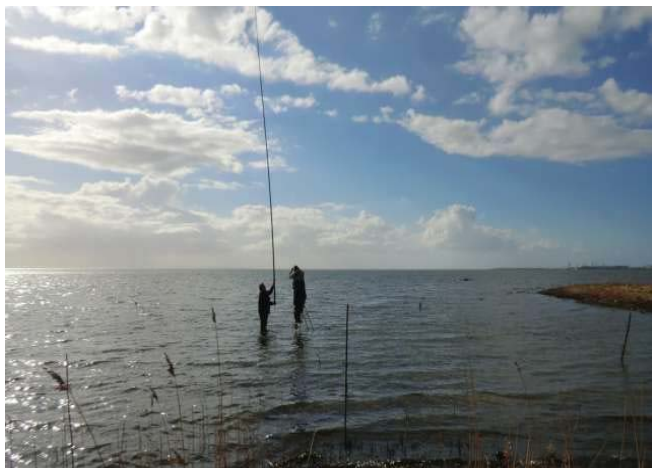
Antenn nummer två fick äran att bli monterad c:a 25 m ut i Öresund. Tillräckligt långt ut för att radialerna skulle få plats med ändpunkterna 50 cm över vattenytan. Montörerna på bild är Thomas SM7JUN och Göran SM7DLK iförda vadarstövlar.
