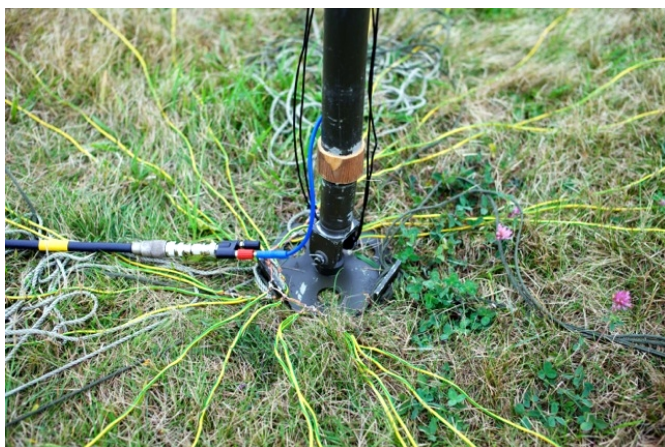
Fig1. Här visas mastfoten med isolerande distans och samliga 24 radialer inkopplade. Inkopplingen av RG-213 skedde som syns på enklaste sätt.
