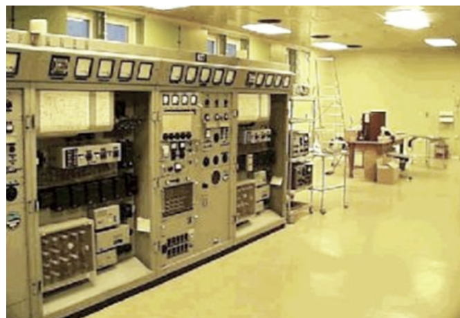
20/30 kW Telefunken effektsteg från 1961
