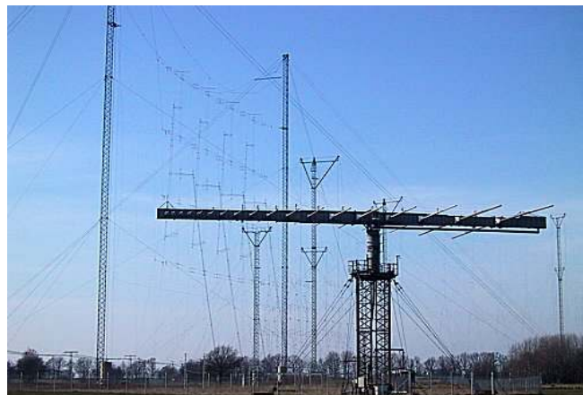
Hörby Rundradio 2007. Gardin- och logperiodiska antenner för kortvåg. (Foto Per Bruhn)
