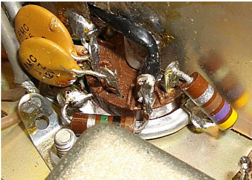
Fig 7. Gallerläckan 1 Mohm flyttades för att komma närmare chassiet. (Minskad antennverkan)
