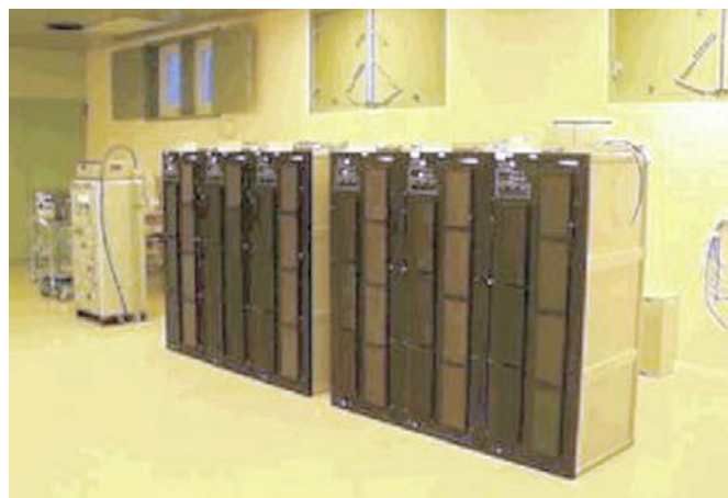
Bild 6. Rockwell-Collins PA-2250 effekttrog
