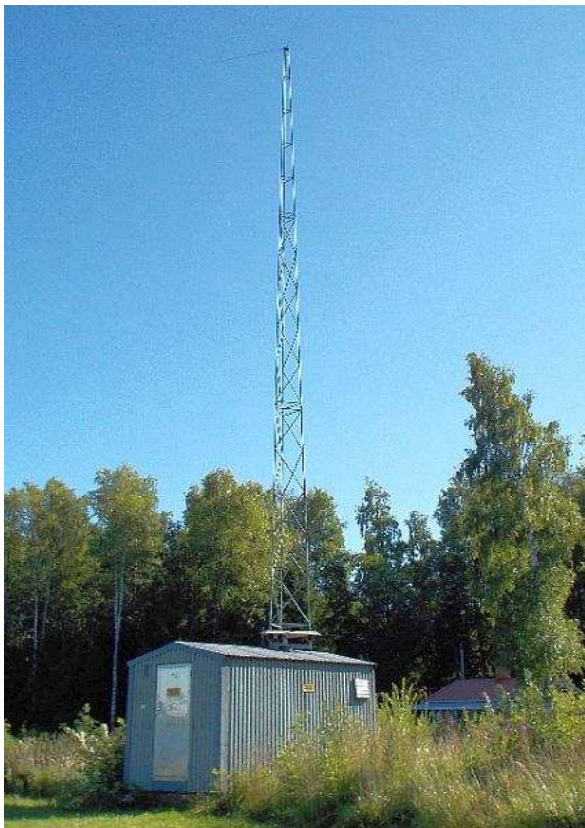
En utrangerad NDB-fyr för långvåg flyttas och blir radiofyr på det nya 600 m amatörbandet.
